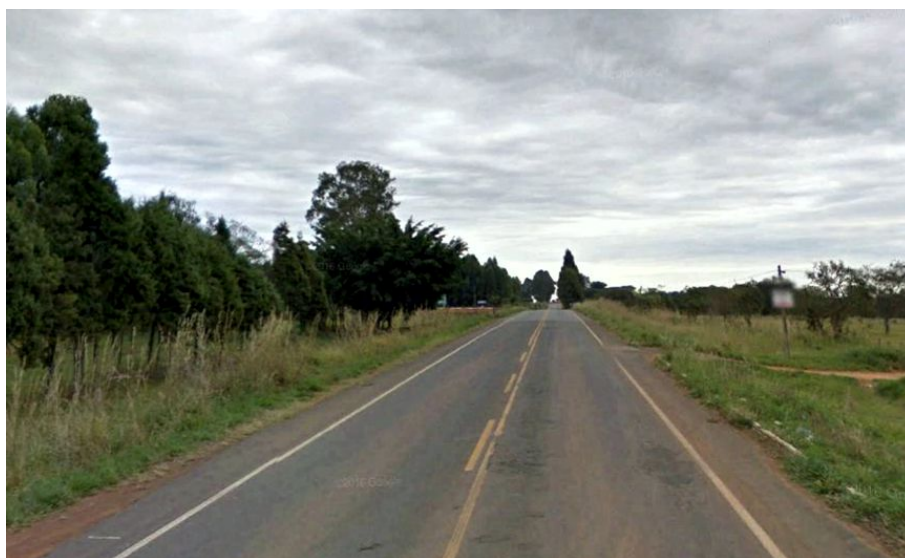
Figura 6 Início do trecho para implantação
